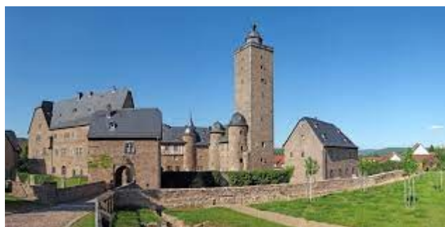
Steinau an der Straße
